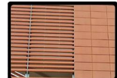
BASAMENTO IN LATERIZIO VENTILATO
