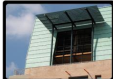
TETTO VENTILATO CON RIVESTIMENTO IN LAMIERA
