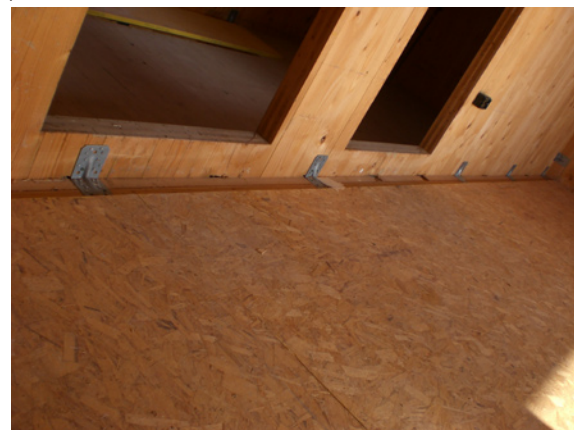
Connessioni metalliche parete-parete e parete - solaio
