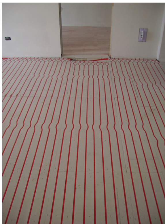
Realizzazione di sistema di riscaldamento a pannelli radianti a pavimento e a parete interamente a secco, con pannelli di gessofibra a serpentina integrata
