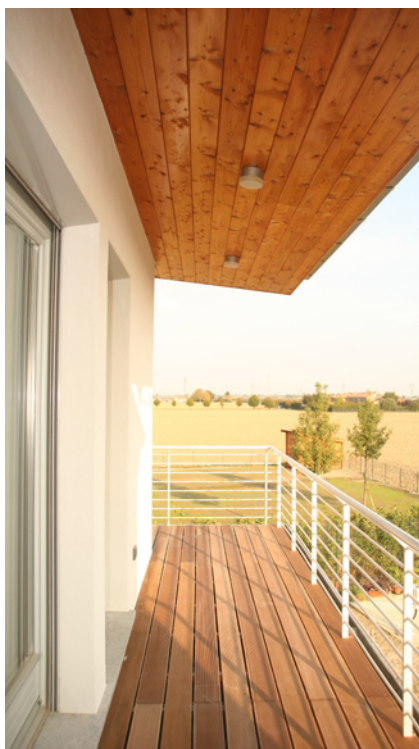
L'ampio balcone a sud, che può essere utilizzato come estensione della zona vivibile verso la campagna e che funge da sistema di ombreggiamento per la vetrata al piano terra
